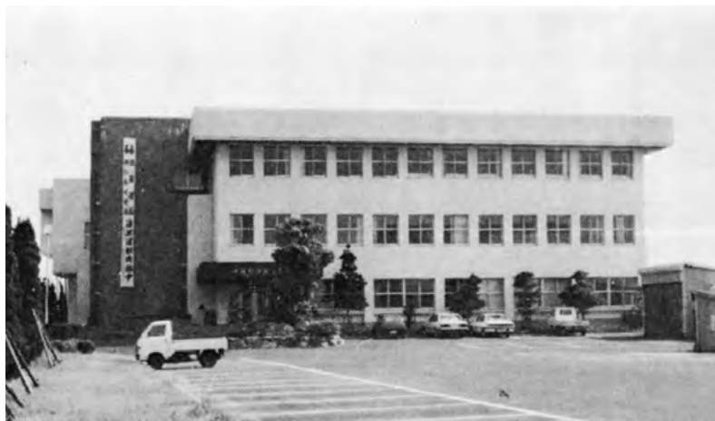
[遠賀町中央公民館]
